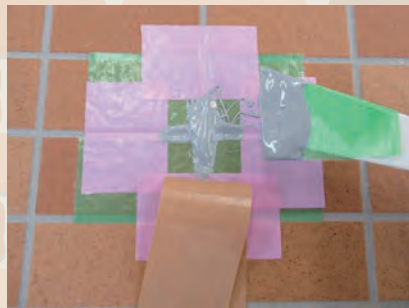
② ガイドテープを貼り付けて目地部にエポキシ系接着剤塗布
