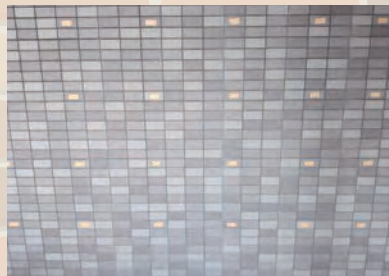
② アンカー位置マーキング
