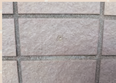
⑧ GNSアンカー打込み完了
