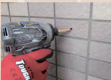
④ 座掘り作業
