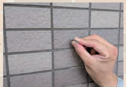
⑥ GNSアンカー挿入
