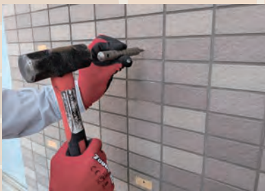
⑦ GNSアンカー打込み
