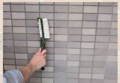
⑨ 洗浄作業
