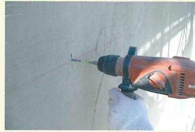
3.GNSアンカーピン穿孔作業
