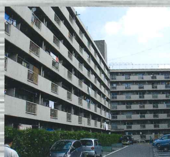
現場全景(千葉県某物件)
