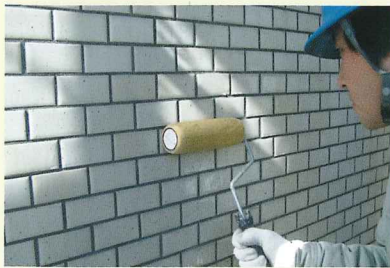
1.GNSプライマー塗布
