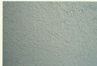
6.新規仕上材の施工
