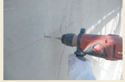
3.GNSアンカーピン穿孔作業
