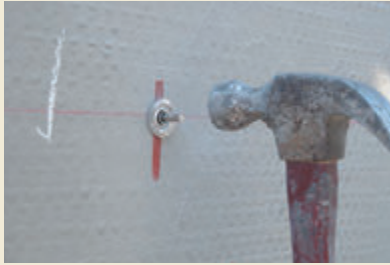
4.GNSアンカーピン打込み作業
