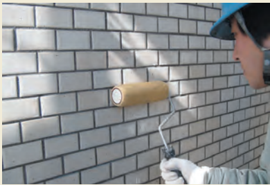
1.GNSプライマー塗布
