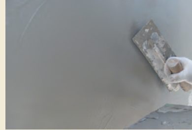
5.GNSフィラーP上塗り
