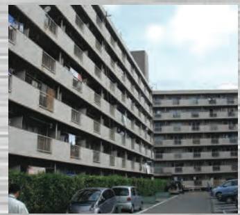
現場全景(千葉県某物件)
