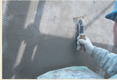
2.GNSフィラーP下塗り+GNSネット埋込み
