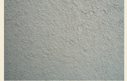
6.新規仕上材の施工
