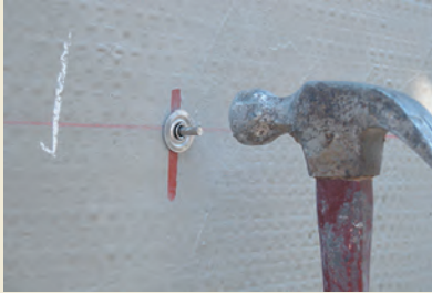
4.GNSアンカーピン打込み作業
