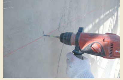
3.GNSアンカーピン穿孔作業
