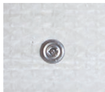
GNSアンカーピンを 1.5ポンドのハンマーで打ち込む
