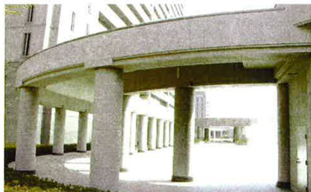
施工例 防衛省本庁舎 全工区
