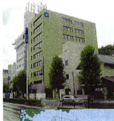
施工前の外観
