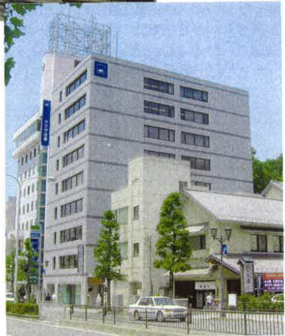
竣工後の建物外観
