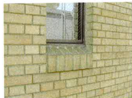
施工前の外壁仕上状況
