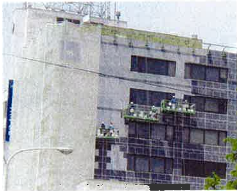
ゴンドラ足場での作業の作業状況
