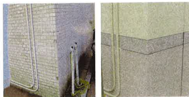
建物腰部のデザイン・タイル凸凹及び角部の補正
