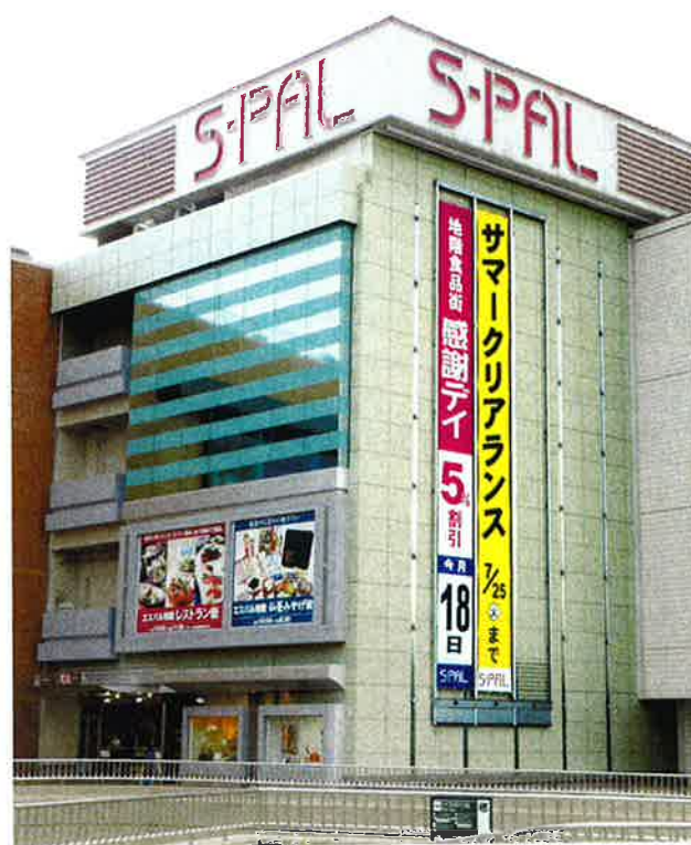
エスパル仙台 施工後の外観
