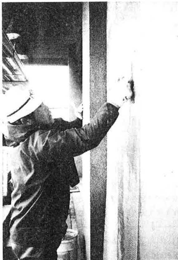
写真2 ビニロン製ネットの張付け
