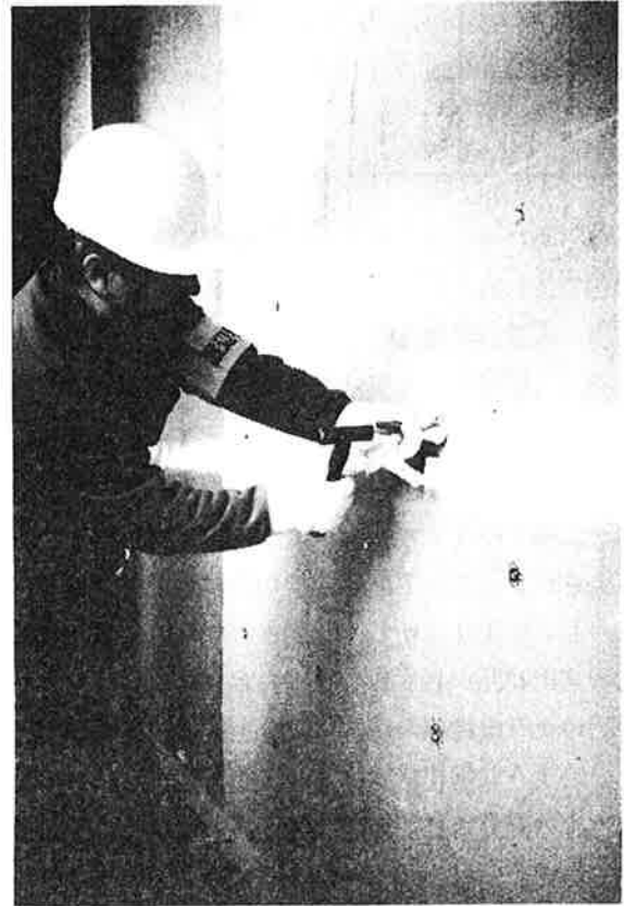
写真3 アンカーピンの打ち込み
