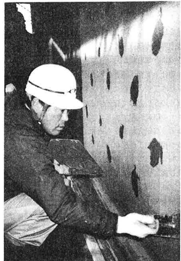
写真4 アンカーピン頭部へのフィラー塗付
