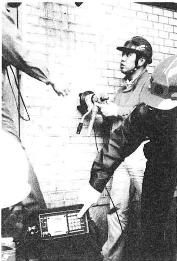
写真5 アンカーピンの引抜き耐力の検査
