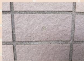
⑧ GNSアンカー打込み完了
