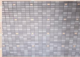
② アンカー位置マーキング
