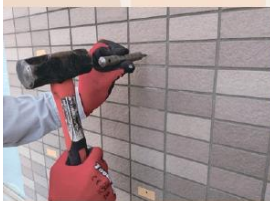
⑦ GNSアンカー打込み
