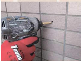
④ 座掘り作業
