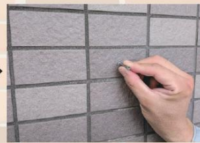
⑥ GNSアンカー挿入
